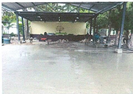
Foto 5: La loza de cemento mejorará, el ambiente del espacio educativo.
