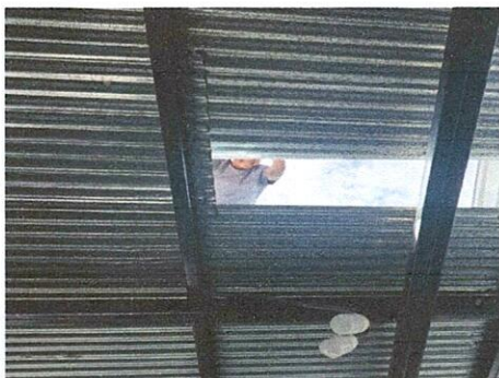
Foto1: Mejoramiento de techo por deterioro
