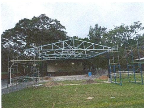
Foto 3: Ampliación de estructura Metálica .
